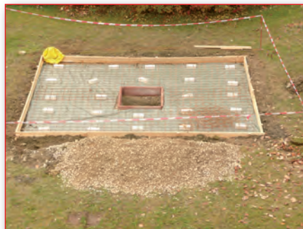
Grube mit Schalung und Armierung
