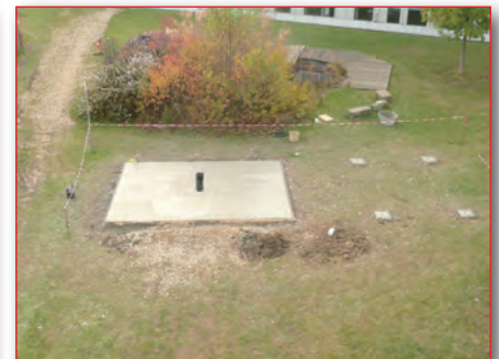
Fundament und Säule
